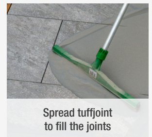
Pour tuffjoint over paving
