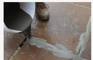
Pour mortar onto wet paving
