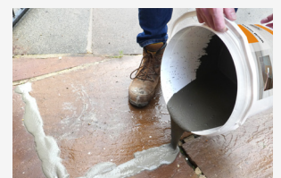
Pour mortar onto wet paving
